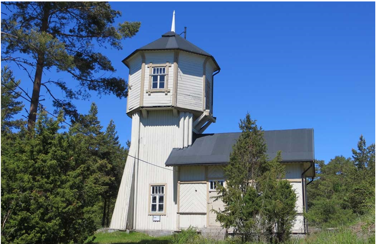
Katanpään linnakesaaren vesitorni ja pumppuhuone.
